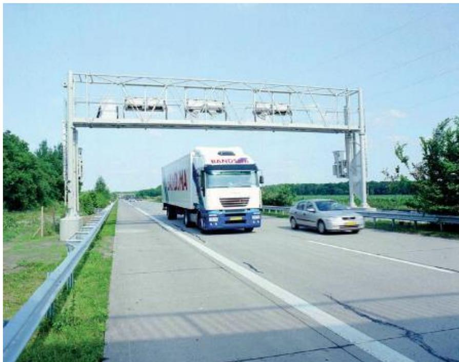
Рисунок 50 - Пост весового контроля в движении
