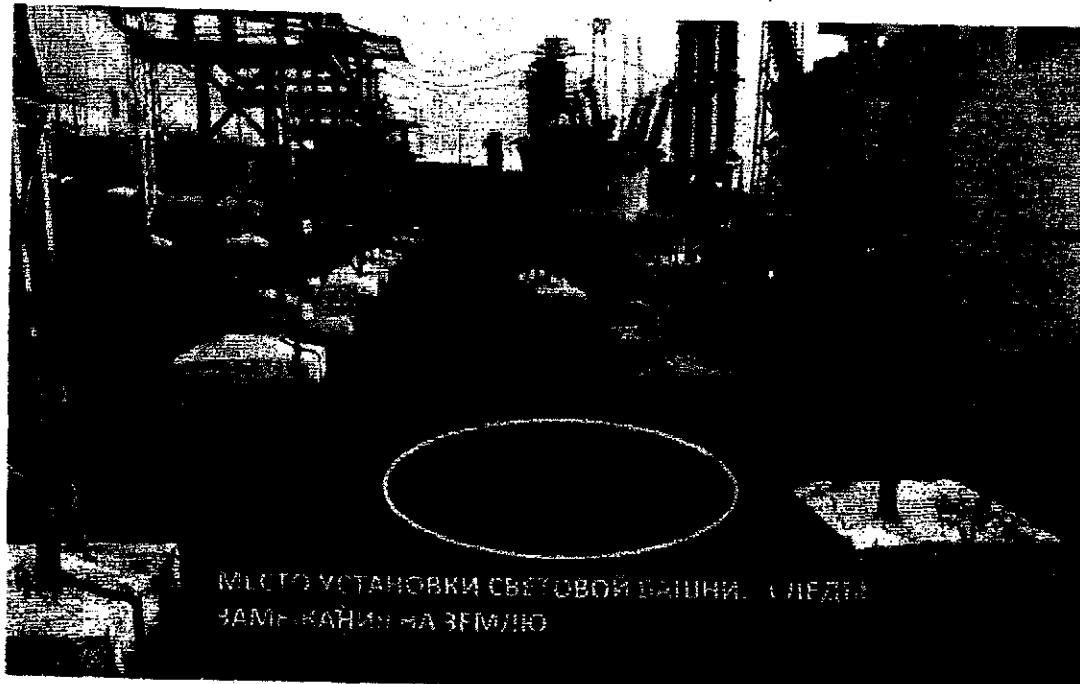
Наряд-допуск был закрыт в 00:17, но переключения для приведения оперативной схемы ПС «Абдулино-тяга» в рабочее положение произведены не были. Для удобства производимых переключений, по устному распоряжению начальника ПС «Абдулино-тяга» световая башня оставалась на территории ОРУ.
